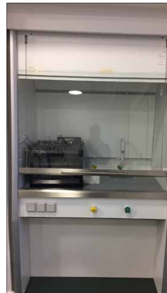
Punktudsug og stinksåbe Næsen er det fineste instrument i FoodLab, så det er af afgørende betydning for madeksperimenterne at duftoplevelserne kan stå alene... derfor den nuancerede rumudsugning med stinksåbe og punktudsug.
