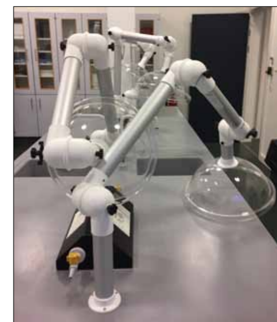
Punktudsug og stinksåbe Næsen er det fineste instrument i FoodLab, så det er af afgørende betydning for madeksperimenterne at duftoplevelserne kan stå alene... derfor den nuancerede rumudsugning med stinksåbe og punktudsug.
